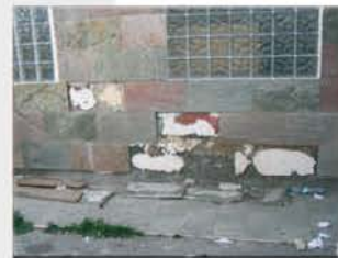
Deficiencias en la colocación
