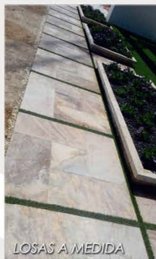
LOSAS A MEDIDA
