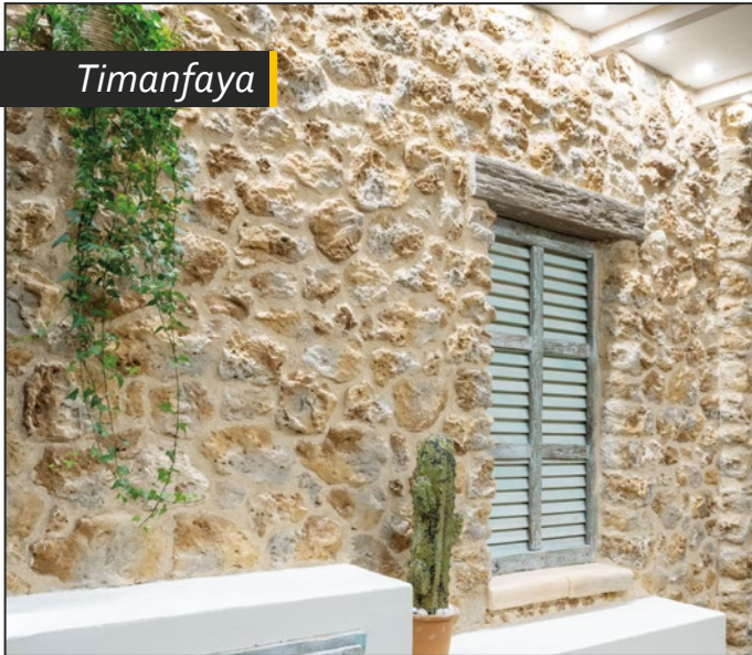
TIMANFAYA castaño rejuntado con MORVER pardo
