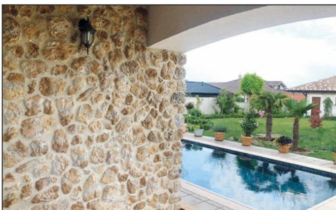
TIMANFAYA castaño rejuntado con MORVER pardo
